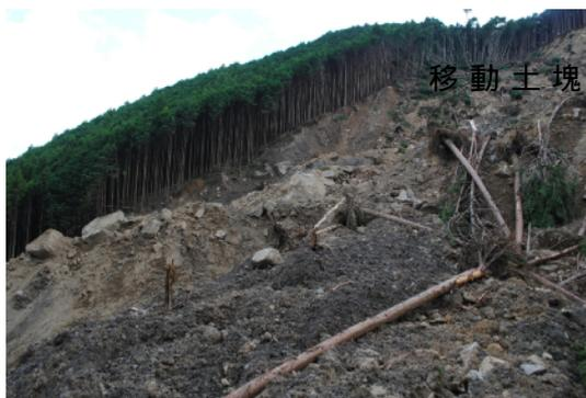
第6図 崩壊部直下の崩土
