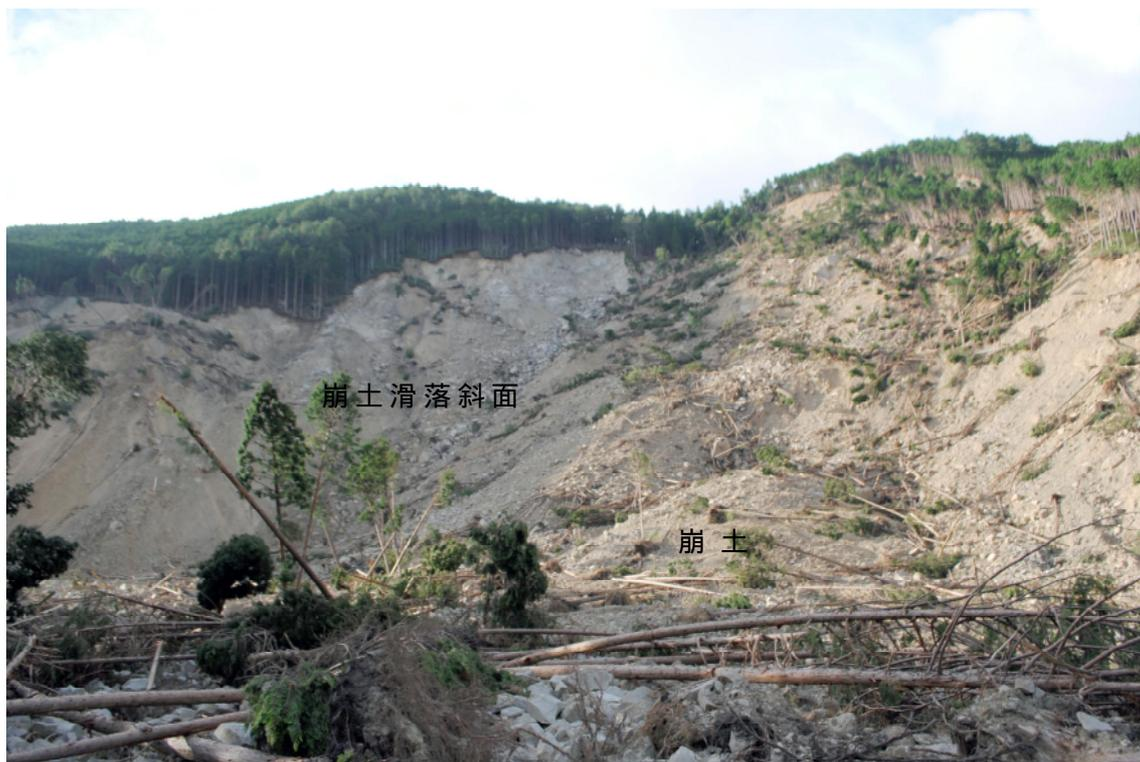
第 1 5 図 崩壊部全景．崩壊部右上方には尾根近くまで多数のクラックが発達する．
